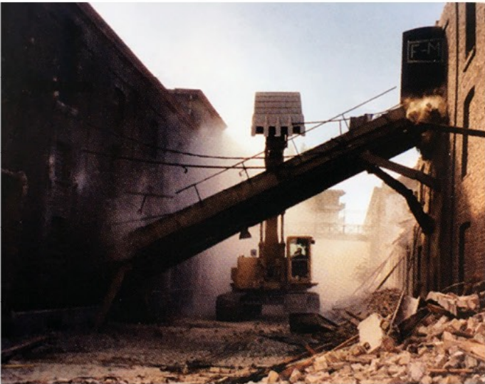
FIG. 14 démolition des anciennes brasseries, 30 octobre 1997 Credits: Koekelberg, au fils du temps, au cœur des rues
